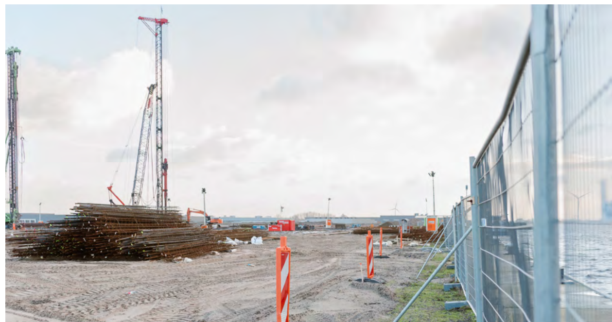
BOUW VAN NIEUWE DUURZAME FABRIEK BUNGE IN ZAA NSTAD | Foto: Joanne de Lijster
