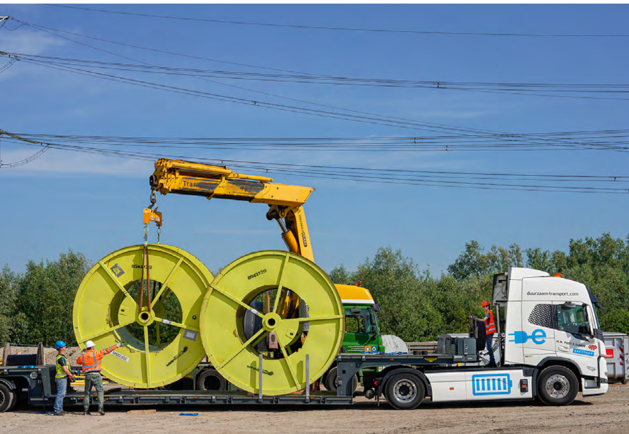
AANLEG INFRASTRUCTUUR IN OOSTZAAN | Foto: TenneT
