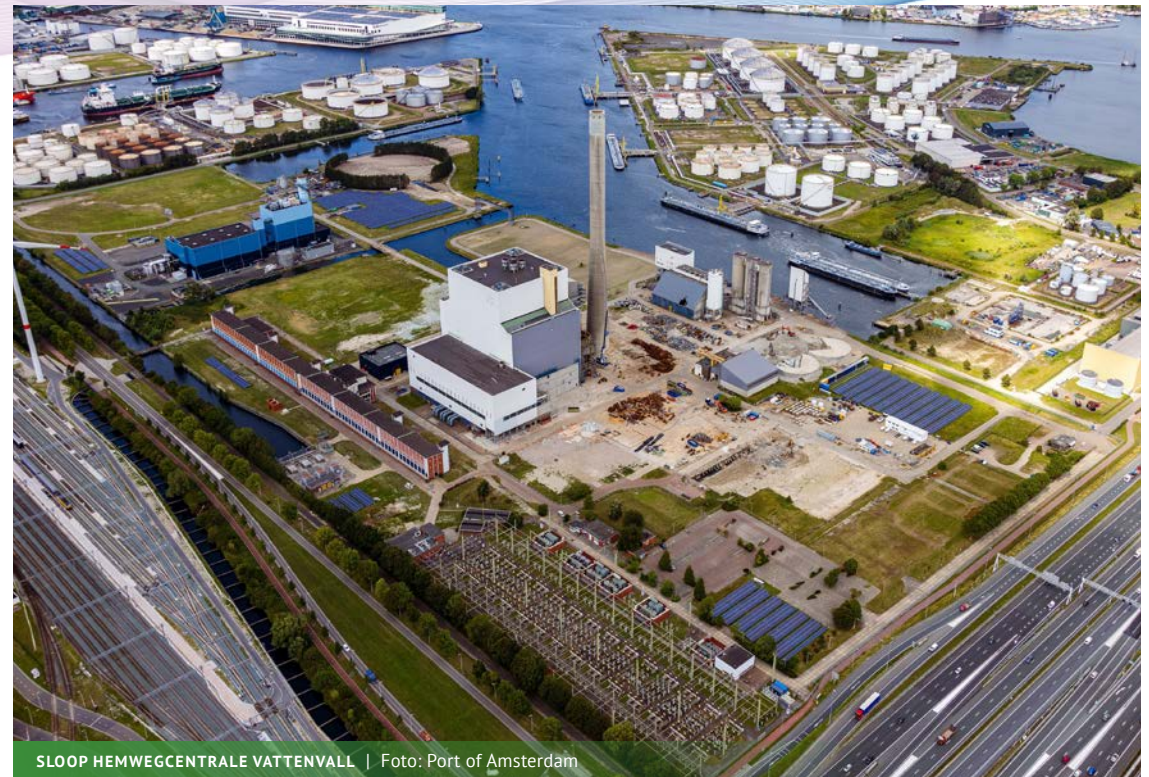
SLOOP HEMWEGCENTRALE VATTENVALL | Foto: Port of Amsterdam
